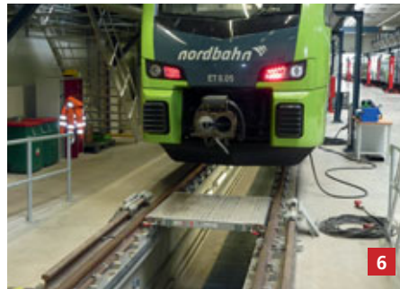
6. Gleisplatten, 2 Stück zum sicheren Überqueren der Gleisgruben
